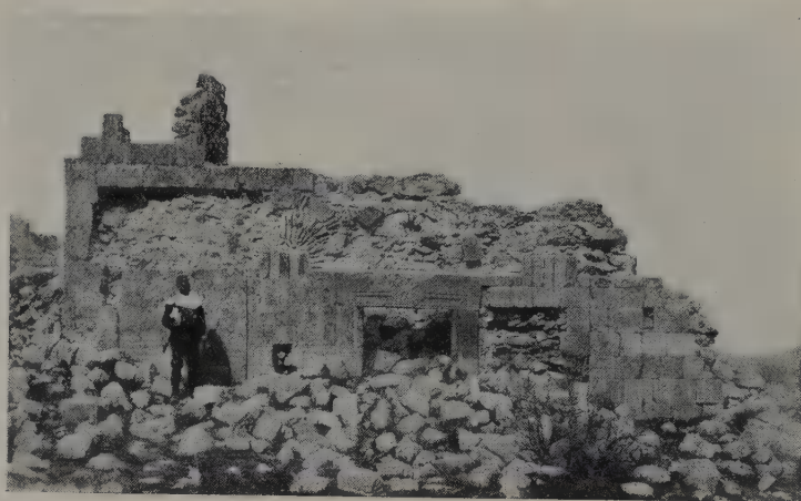
FIG. 153.—No. 35, W. facade.
